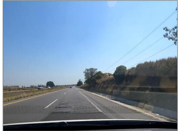
Carril de baja velocidad con deterioros superficiales en pavimento, en el Libramiento el Perote en el km 108+200, cuerpo derecho.
