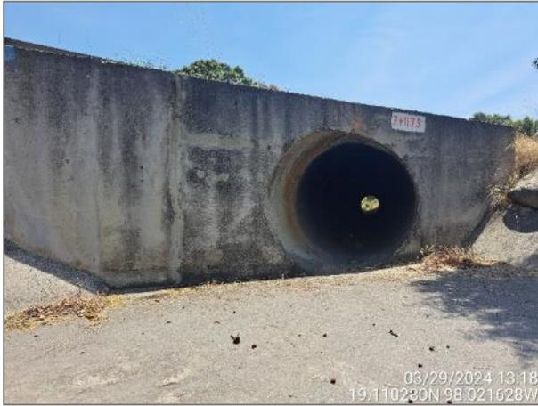
Vista general de obra de drenaje en buenas condiciones físicas y libre de azolve, en el km 7+875, lado izquierdo.
