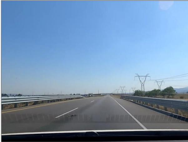
Se aprecia bache en carril de baja, así como señalamiento horizontal fuera de norma (10 cm aproximadamente de ancho de raya), en el Libramiento el Perote en el km 101+100, cuerpo derecho.
