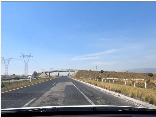
Se apreció deterioro en superficie de rodamiento del carril de baja y falta de barrido en acotamiento derecho, en el km 107+600, cuerpo izquierdo
